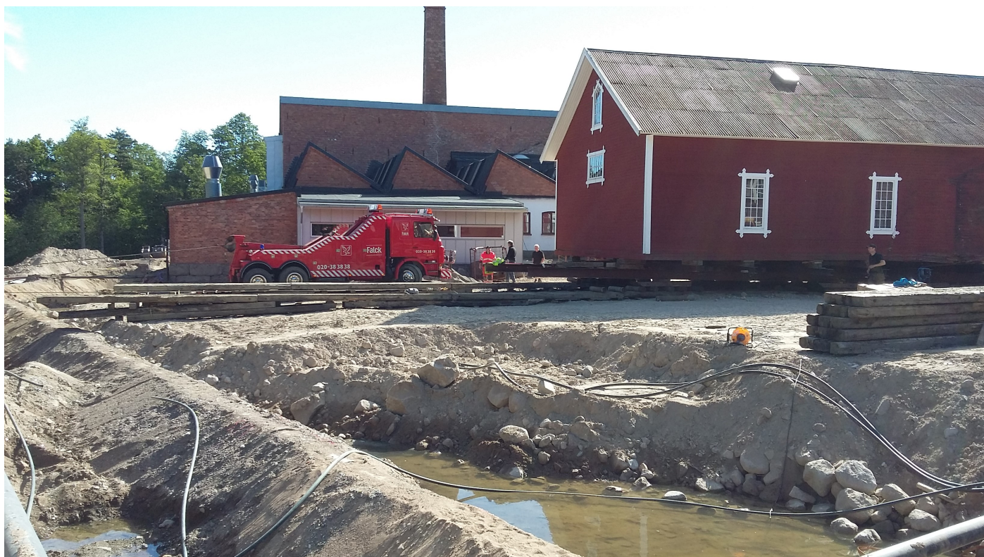
Hantverkshuset drogs bakåt hela sin längd på trärullar av en tungbärgare .
