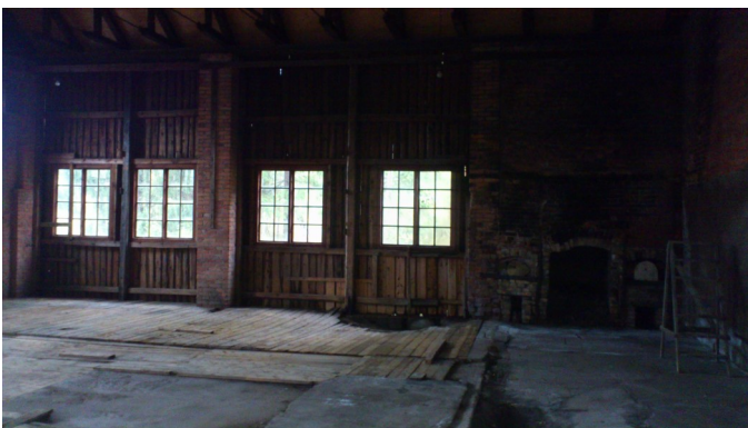
Före och efter saneringen av Sodafabriken
